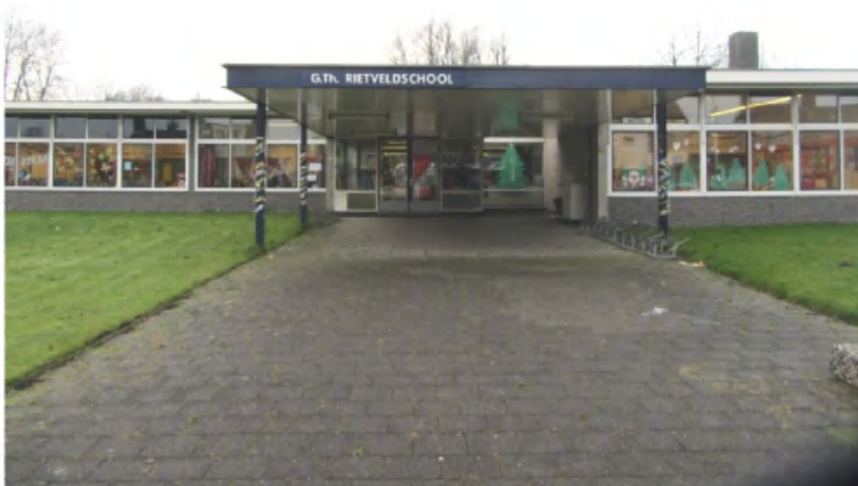
G. Th. Rietveldschool (bestaande te handhaven bebouwing, Edisonstraat 3)
